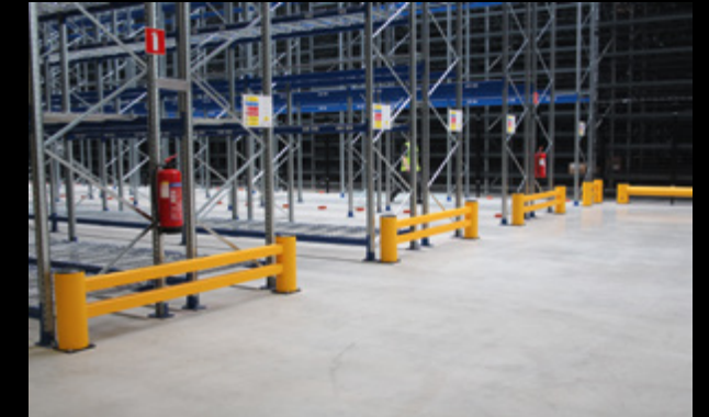
► Extrémité du rayonnage / protection de rayonnages
